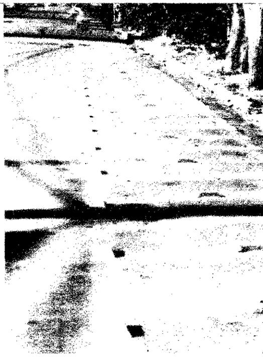
Foto 7 e Foto 8 – Instalação de tachão (sinalização horizontal) na AV Florindo Cassano
