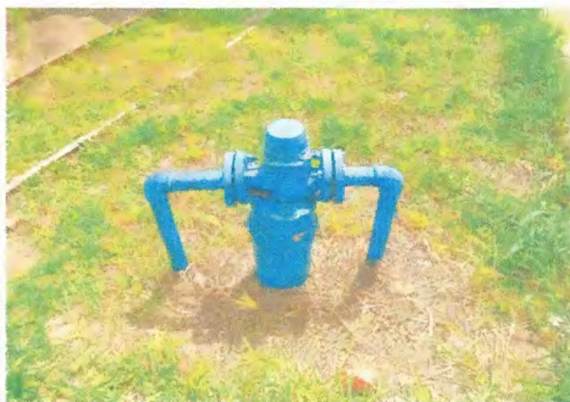
Figura 35 – Macromedidor P4.
