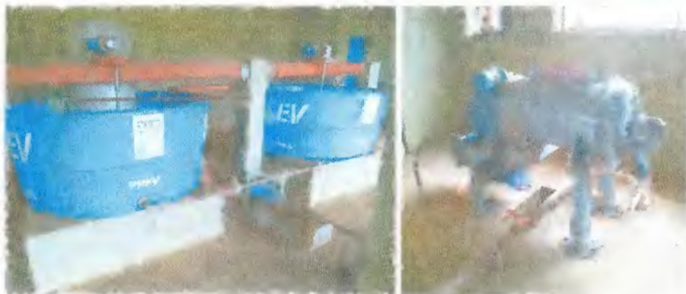
Figura 48 – Equipamento para dragagem do lodo da ETE.
