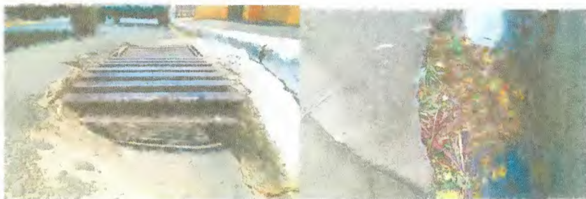
Figura 64 - Estruturas de Boca de Lobo em Saltinho.
