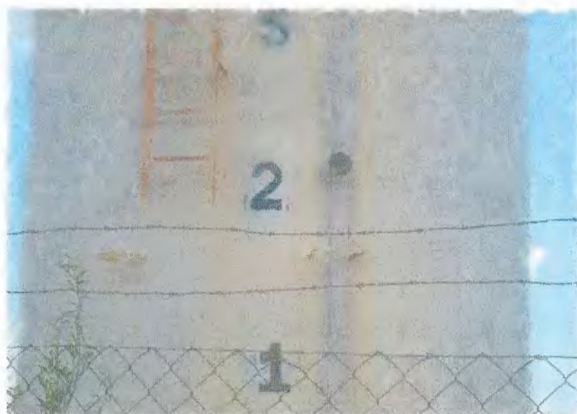
Figura 32 - Régua de medição de nível do reservatório.
