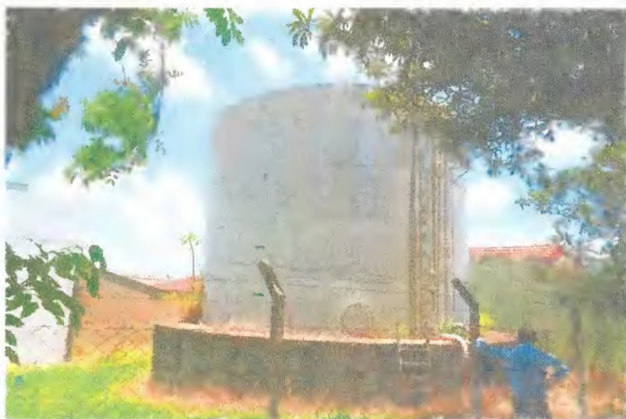
Fonte: B&B Engenharia Ltda., 2014. Figura 28-- Reservatório Agrolar.
