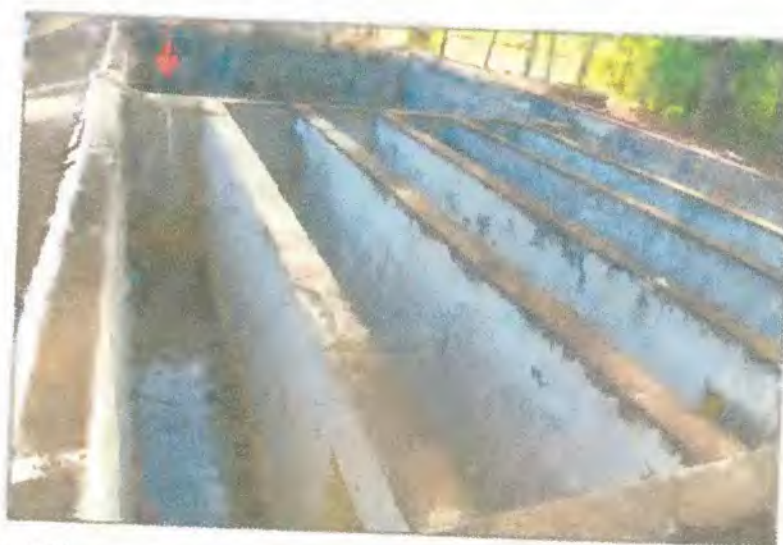
Figura 46 - Adição de cloro e tanque de contato.
