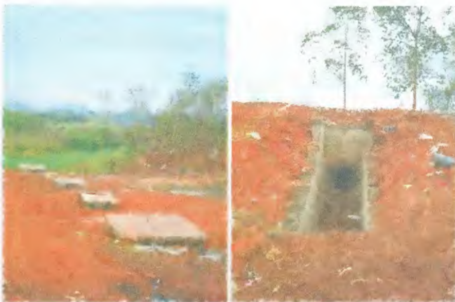
Figura 62 - Galerias para escoamento de águas pluviais.
